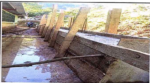
foto 4. el muro perimetral esta finalizado.
