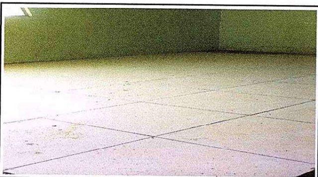
foto 3. el piso ceramico esta instalado en su totalidad
