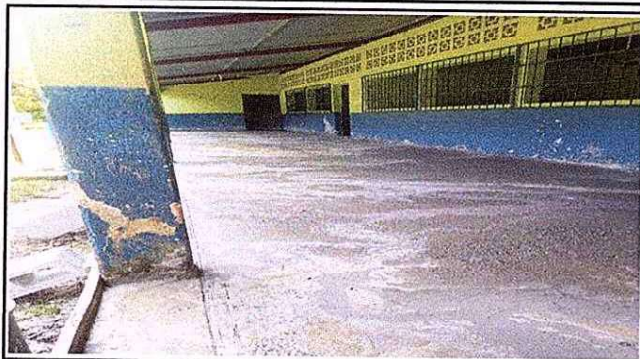
foto 1. el corredor del establecimiento esta terminado
